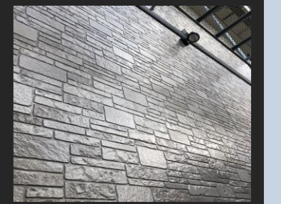
▲塗り替え後 (UV4Fプロテクトクリヤーで施工)
