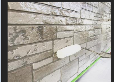
▲上塗り (UV4Fプロテクト4Fクリヤーで施工)
